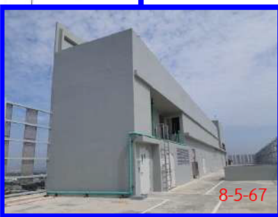
ถังเก็บน้ำชั้นดาดฟ้า 1 และ 2 มีปริมาตรเก็บกักรวม 143.76 ลบ.ม.
